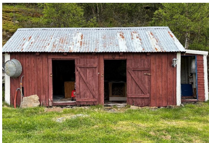
Uthus med lagringsrom, vedbod og utedo
