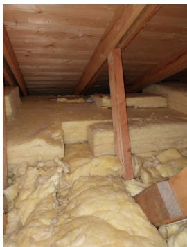
Noe varierende tykkelser av mineralull på kaldtloft.
