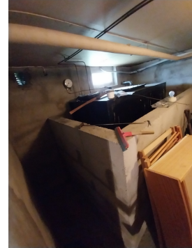
Oljetank plassert i kjeller, tank delvis innmurt i krybbe
