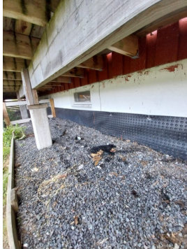
Manglende topplist ved avslutning av drensplater.
