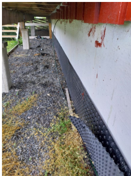
Manglende topplist ved avslutning av drensplater.
