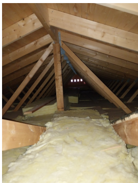
Begrenset besiktigelse av kaldtloft ved tilbygg fra åpning i bordtak ved opprinnelige del.
