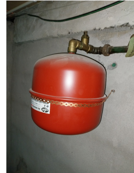
Ekspansjonstank tilknyttet fyrkjel/bereder.
