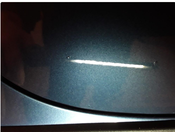
1.4 Steinsprut med korrosjon.
