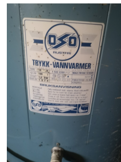
Varmtvannsbereider fra 1974. 1500 watt
