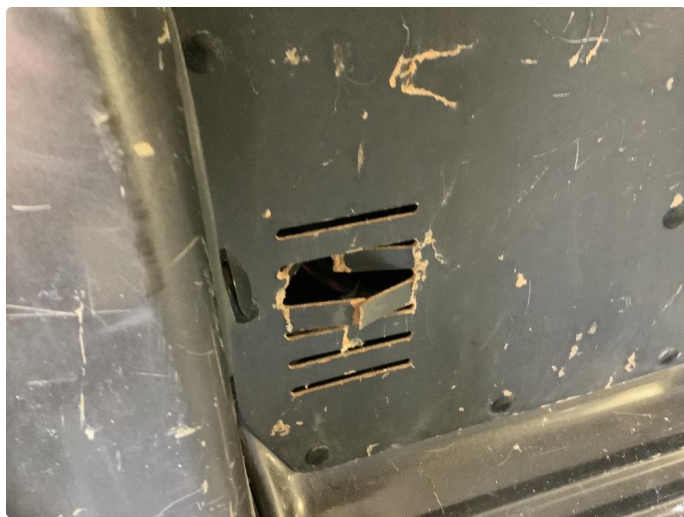
2.1 Div Riper / Små Skader i Vare Rom
