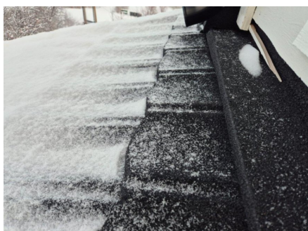
Tak er tekket med takpanner.
