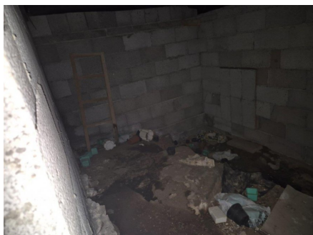
Kryp kjeller under deler av boligen.
