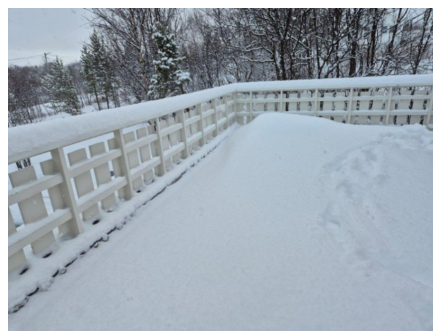
Veranda over garasjetak.
