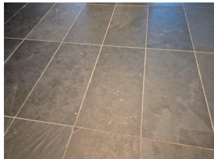
Flislagt gulv i hall i underetasje.
