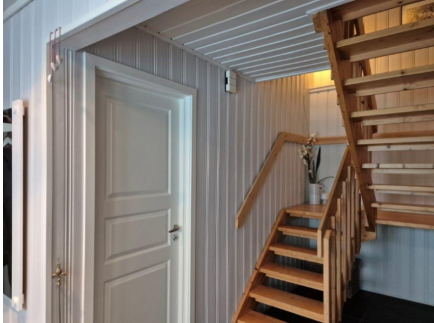
Trapp i tre med rekkverk og håndløper på vegg.
