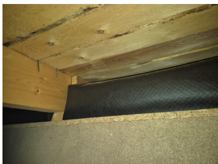
Luftespalte i isolert skråtak/himling.
