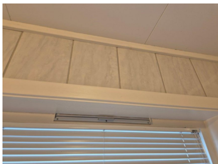
Spalteventil i vindu.
