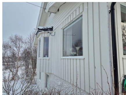
Utvendig kledning av malt tømmermannspanel.
