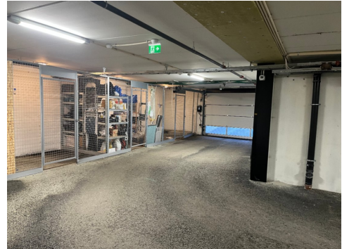
Felles parkeringskjeller med boder.
