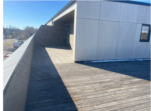
Tak over inngangspartier til terrasse.
