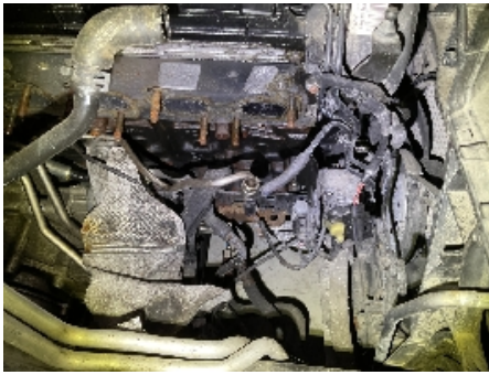
25. Utvendig tilstand motor
