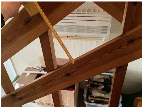
Åpning er større enn dagens krav
