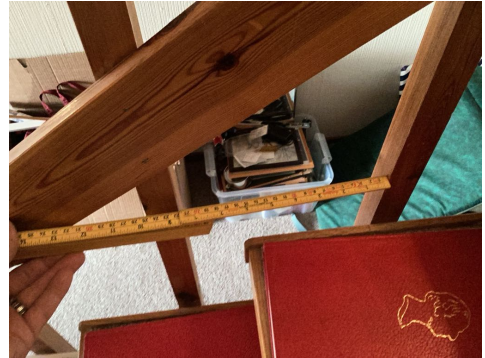
Åpning er større enn dagens krav
