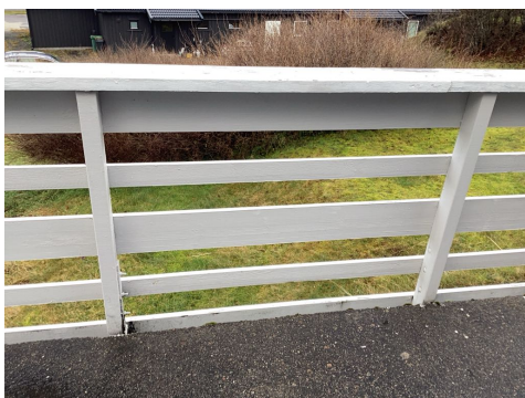
Åpning er større enn dagens krav
