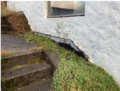
Deler av fluktsikring ligger under terreng
