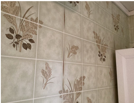
Våtromstapet løsner i kjøter
