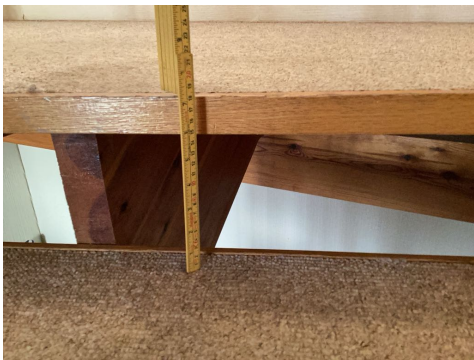
Åpning er større enn dagens krav
