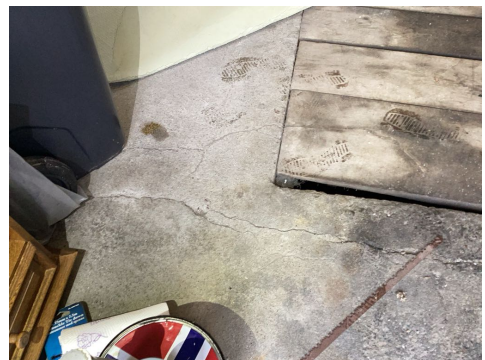
Sprekk i garasjegulv
