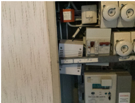
Løse komponenter i skap
