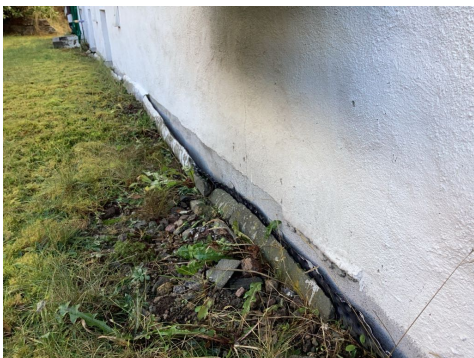
Deler av fluktsikring ligger under terreng
