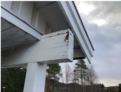
Skader på drager
