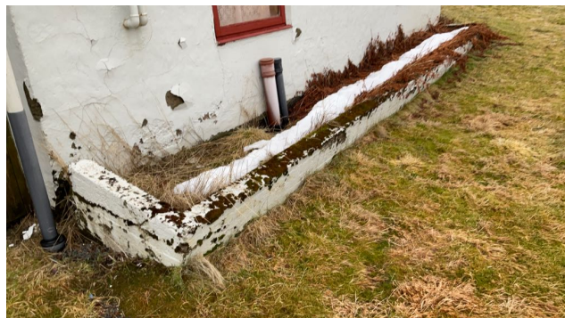
Utsnitt av murer ved fasade mot sørvest
