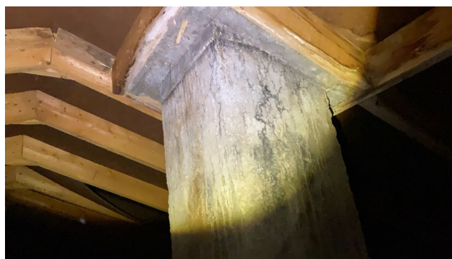
Utsnitt av pipe på kryploft.
