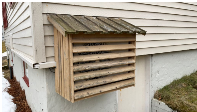
Utedel med innkassing montert på fasade mot sørøst.
