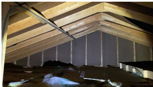
Utsnitt av takkonstruksjoner.
