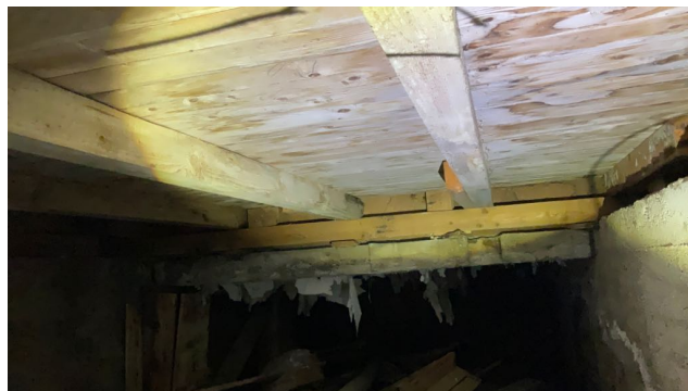
Underside av bordgolv i vindfang.
