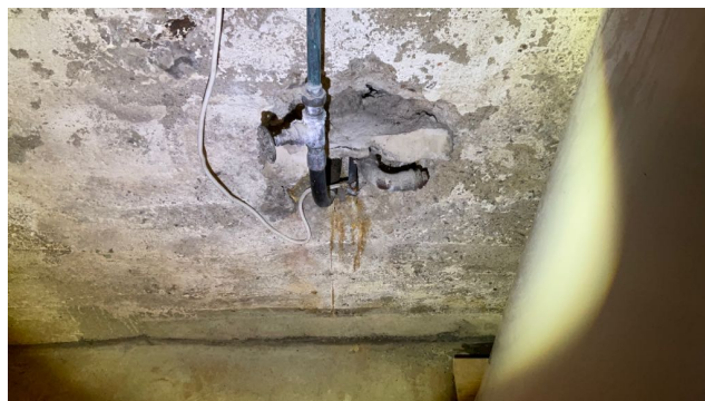
Stengeventil i kjeller.
