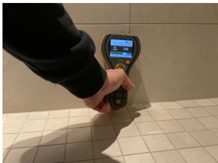
Fuktmåling i dusjsone
