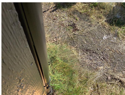
Frostsprengt nedløpsrør.
