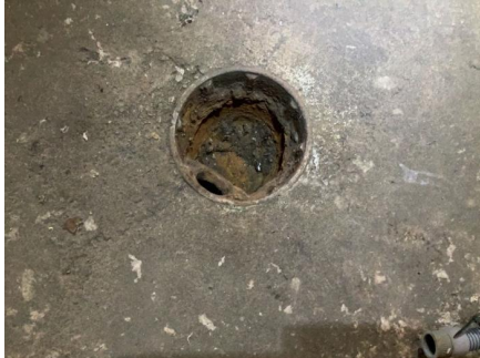
Støpejernsluk i betonggulv i kjeller.
