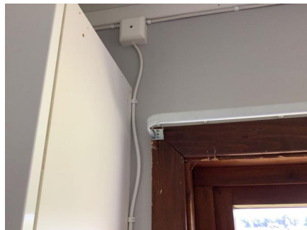
Ufagmessig montering på kjøkken.
