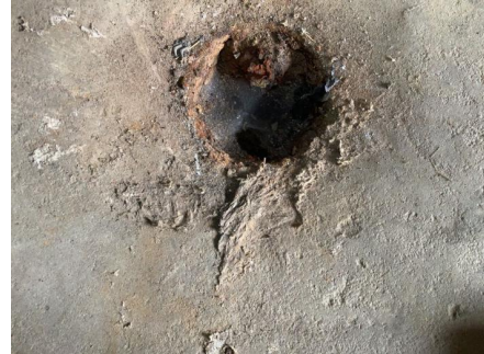
Støpejernsluk i betonggulv i kjeller.
