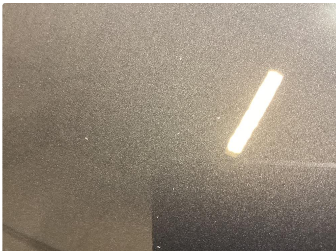
1.1 Stein sprut fram kant av panser
