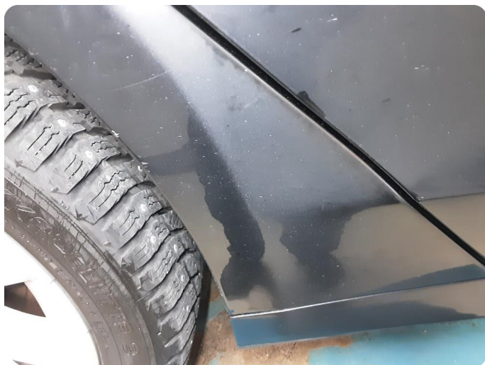
3.8 Ripe(r) ned til grunning
