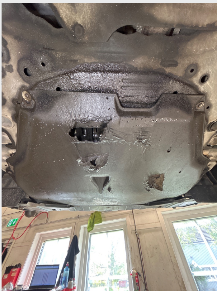
5.11 Mye svinging motor, lekkasje?
