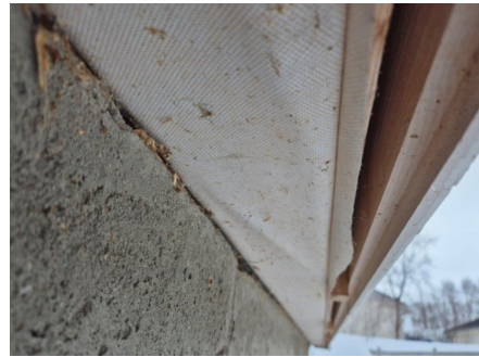
Bilde tatt i nedre del av vegg og viser utforet og etterisolert ytterveggkonstruksjon.
