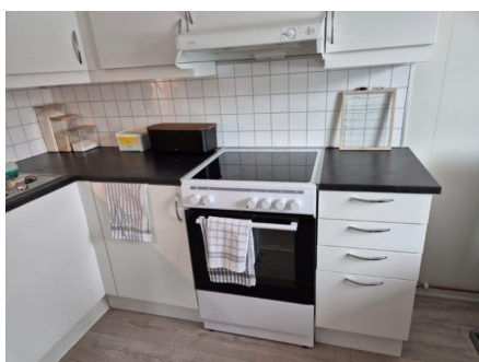
Avtrekk/ventilator over komfyr.
