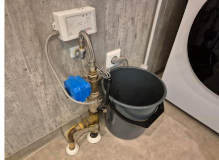
Vanninntak i bad/vaskerom med kombinasjon av eldre og nyere rør.
