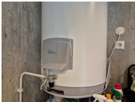
Høiax 187 liter varmvannsbereder.
