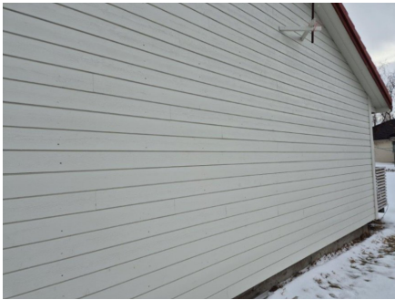
Yttervegger er kledd med liggende malt trepanel.
