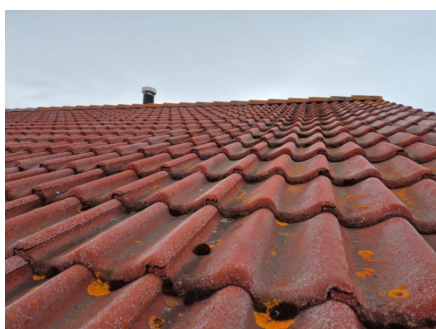
Yttertak er tekket med betongtakstein.
