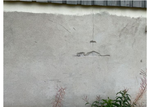
sprekk i grunnmuren
