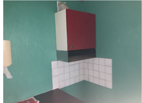
ventilator gammel avtrekk ut
