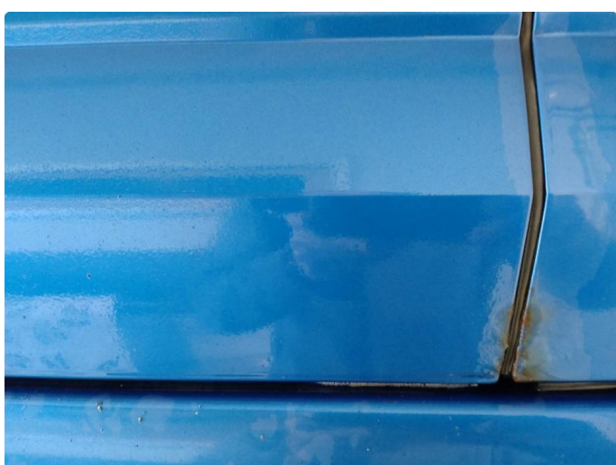
1.3 Rust/korrosjon
