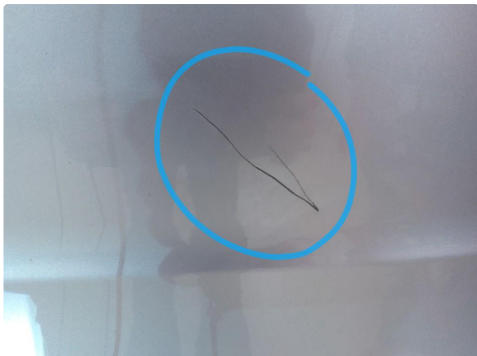
1.1 Ripe ned til grunning
