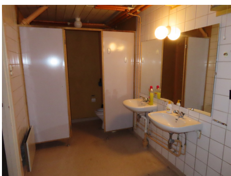
Del av bad/vaskerom i u.etg. Toalettavlukke bak lettvegg. Porselensservanter.
