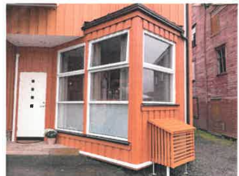
Vinduer i stue/kjøkken.
