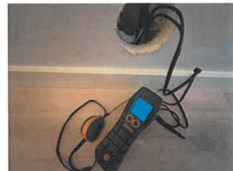
Hulltaking i vegg mellom dusjnisse og stue.
