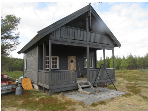
Trapp/terrasse og balkong.
