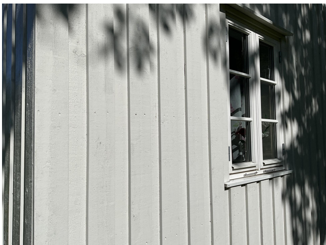
Stående kledning fra 2017.
