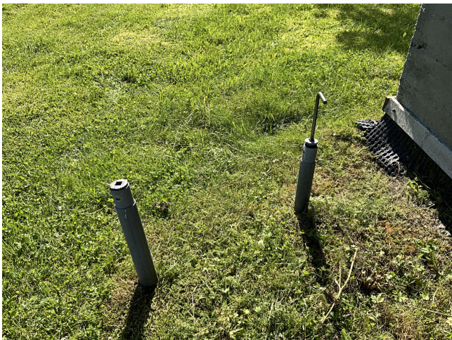
Hoved stoppekran ute ved hushjørner.
