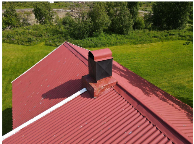
Skorstein av støpt betong over taktekke delvis med metallbeslag på toppen.
