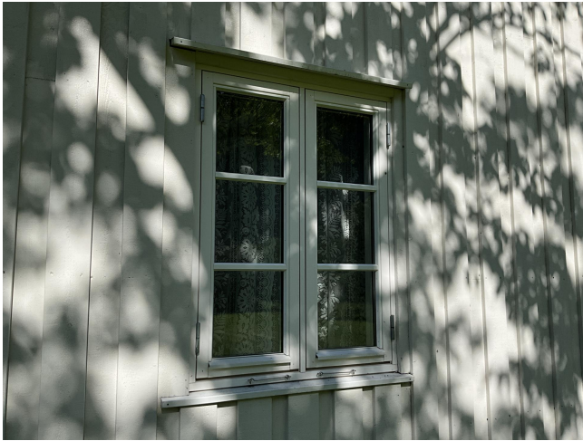
Vindu utvendig fra 2017.
