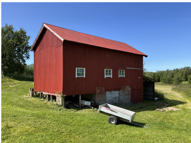
Fjøs utvendig, bakfra.
