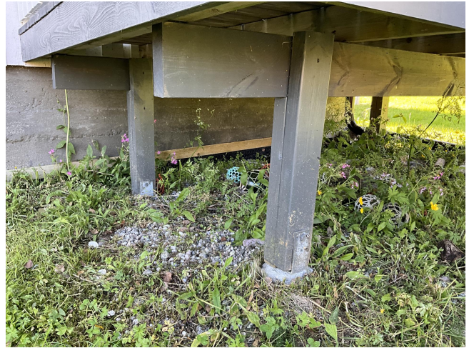
Underkonstruksjon av impregneret material og betongsøyler som fundament.
