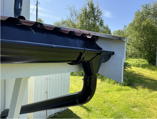
Takrenner og nedløpsrør av metall.
