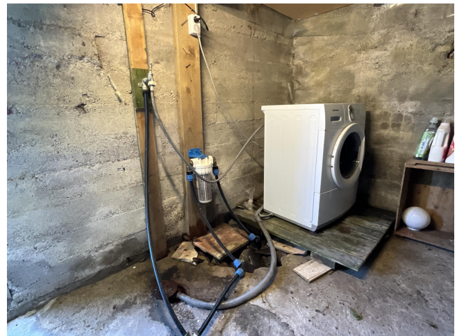
Vannfilter er etablert for innkommende vann.
