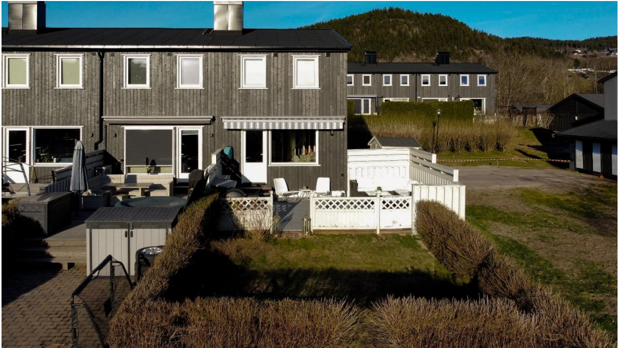
Fasade: fremside og plattform
