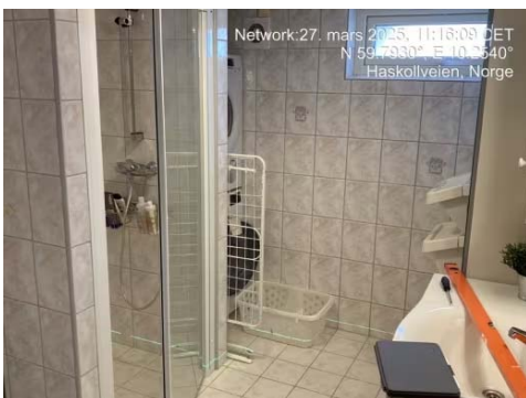
Bad i kjeller
