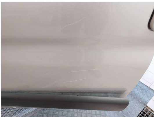
1.5 Flere bulker på framdør v.s, Dekksel er løs ved framdør, Rust i fals v.s
