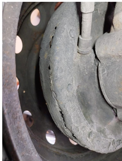
5.2 Ankerplate på bakakksel er gjennomrustnet
