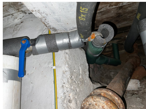
Avløpsrør fra toalettrom.
