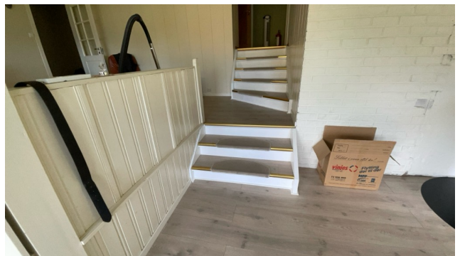
Lavt rekkverk på repos/ mellomnivå.
