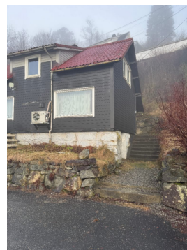
Betongtrapp mangler rekkverk
