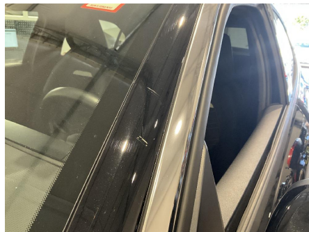
3. Venstre utvendig synlig A-stolpe/takvange
