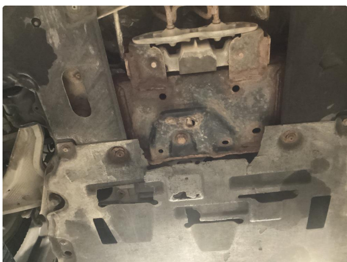
1.2 En del overflaterust
