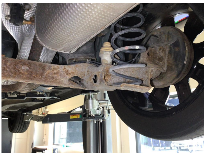
3.1 Overflaterust i bakstilling, ingen tiltak kreves
