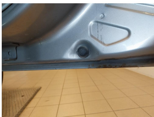
2.9 Steinsprut med rust på h.s framdør
