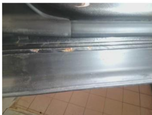
1.5 Rust i fals
