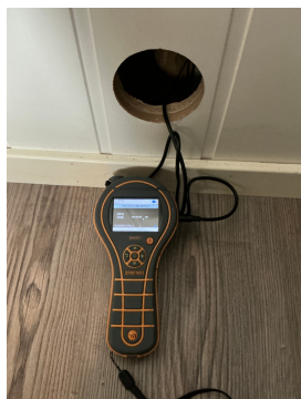
Fuktmåling i tilliggende konstruksjoner
