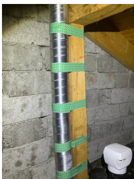
Murt vegg mellom brannceller (boenheter)
