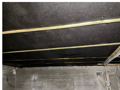
Etasjeskiller i kryp kjelleren
