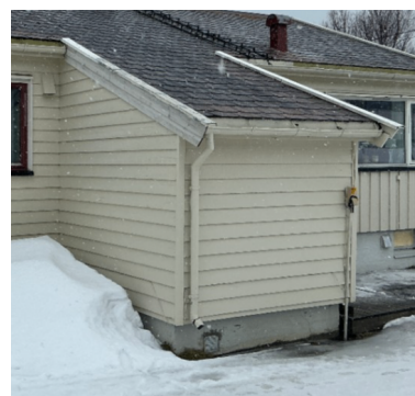
Taket over inngangspartiet
