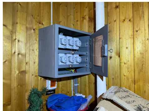
Sikringsskap for hovedstrøm,
