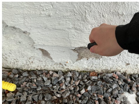
Avflassing av puss
