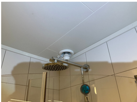
Avtrekk i himling over dusjen
