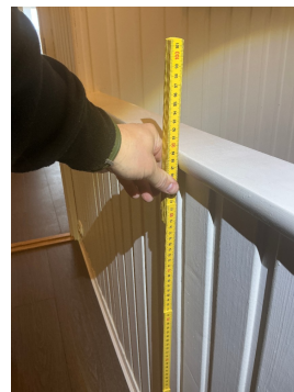
Rekkverk mellom 1. etasje og kjeller
