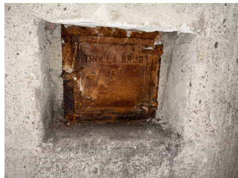
Sotluke i kjelleren
