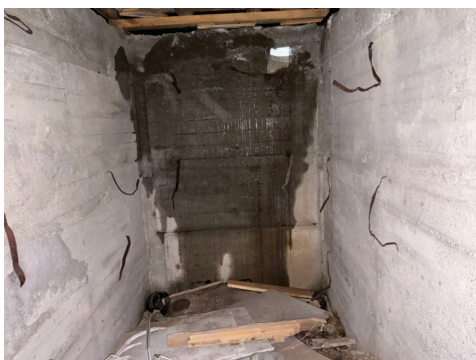
Kryperom under inngangspartiet
