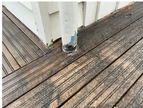
Nedløp mot grunnmur
