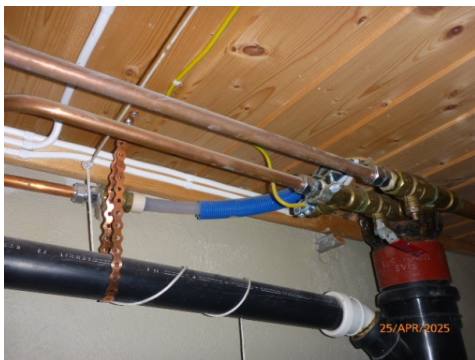
Vann og avløpsrør i kjeller.
