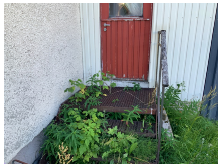
Utvendig strekkmetall trapp far yttergang
