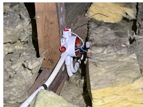
Veggbox på kryploft mangler dekkelukk.
