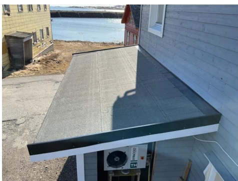
Taktekke over fryserommet
