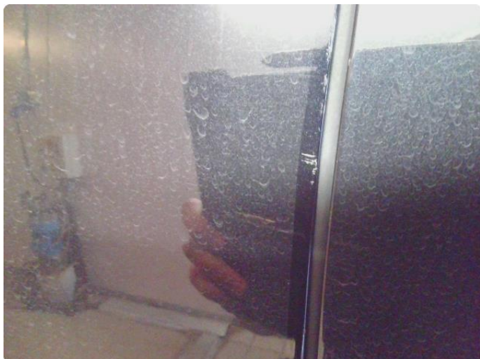
1.2 Steinsprut med rust
