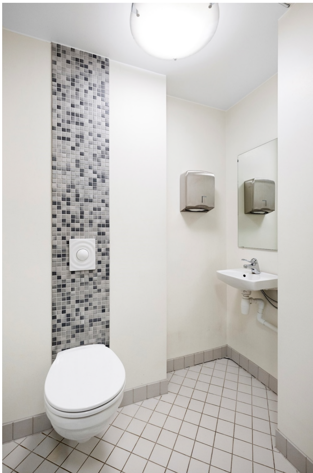
Flislagt toalettrom med vegghengt wc.
