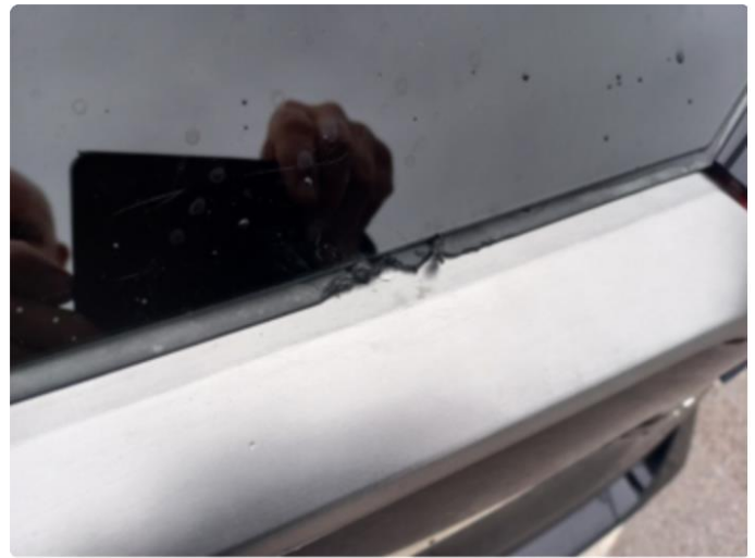
1.3 Noe skadet pakning bak.
