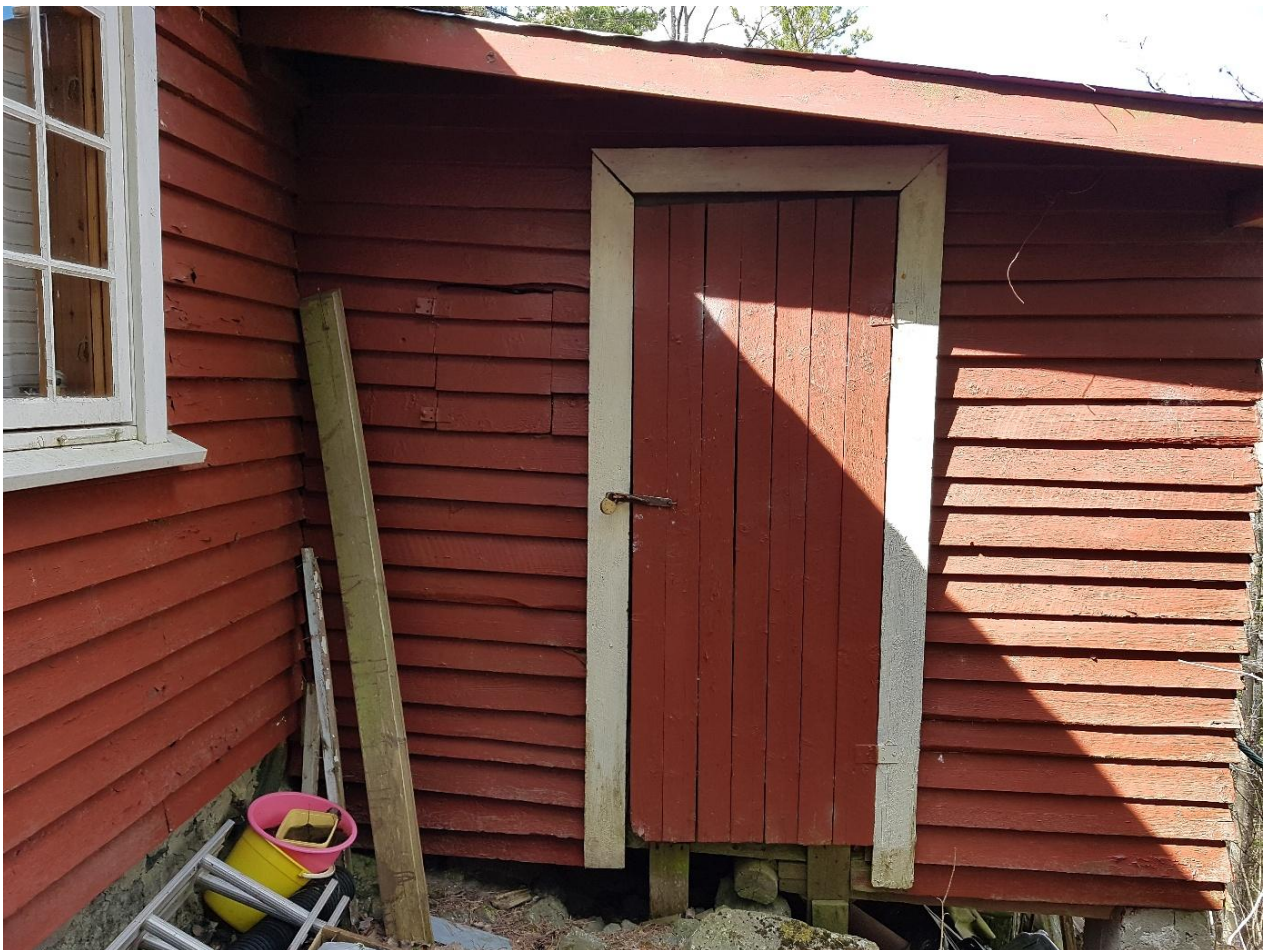
Vedskjul med utedo på østsida av hytta (luke til sikringsskap sees ved siden av døra)
