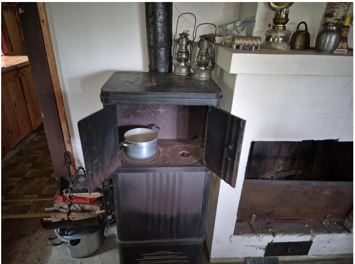
Vedovn og peis på stuevegg mot sør
