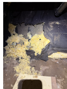
Det er spor etter mus i isolasjon mot mur
