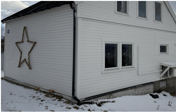
Bakre/øvre del av krypkjeller ikke tilgjengelig
