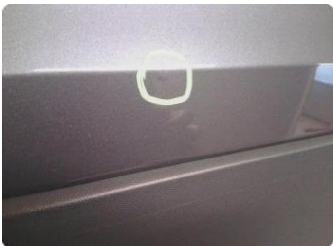
1.2 Steinsprut med korrosjon.
