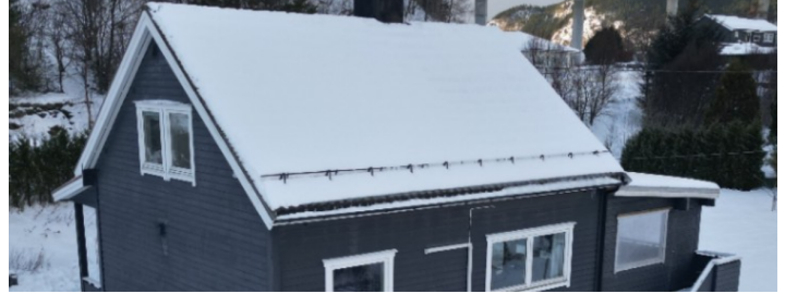
Oversikt tak. Snødekket på befaringdagen.
