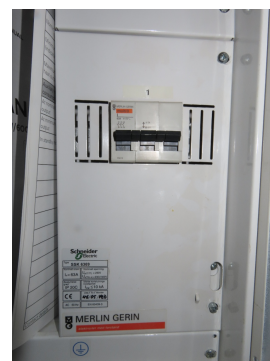
3-faset inntakssikringer/hovedsikringer.
