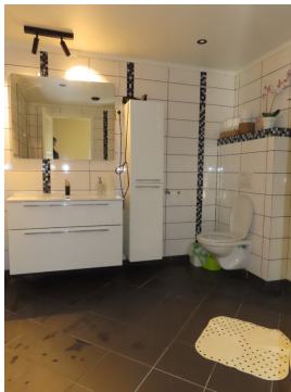
Baderomsinnredning/servantskap med helstøpt servantplate. Vegghengt toalett med innebygd susterne.
