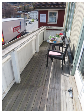
Åpen balkong/veranda med adkomst fra stuen.
