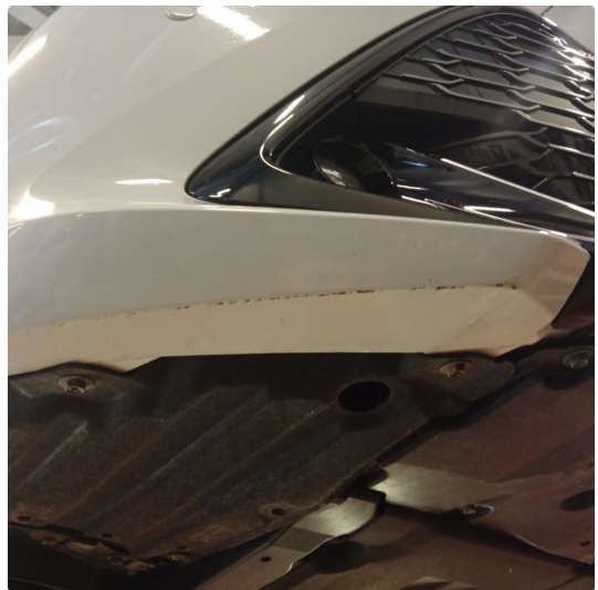
1.7 Riper og diverse steinsprut. Lakkere
