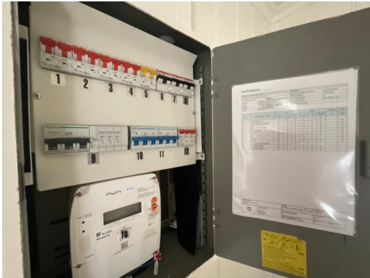
EI.skap - Hovedetasje
