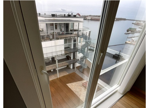
Stuevinduer i fasade mot sørøst - sett fra innvendig side
