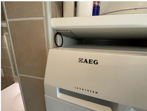
Overkant av fordelerskap ved overkant av tørketrommel.
