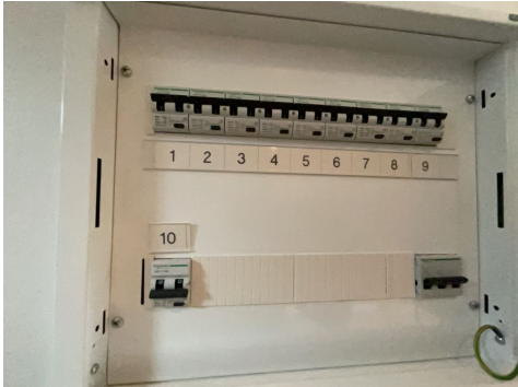
Utsnitt av sikringselementer.
