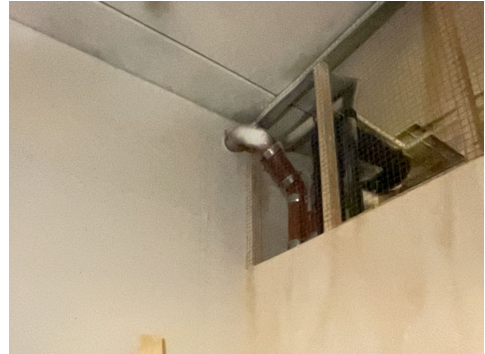
Utsnitt av avløpsrør i fellesareal - soil.
