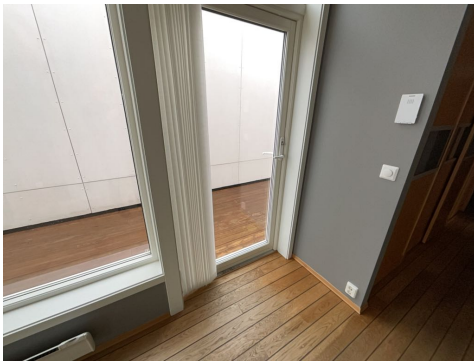
Verandadør til takterrasse - sett fra innvendig side.
