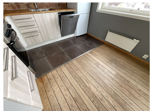
Fliser ved del av kjøkkeninnredning.
