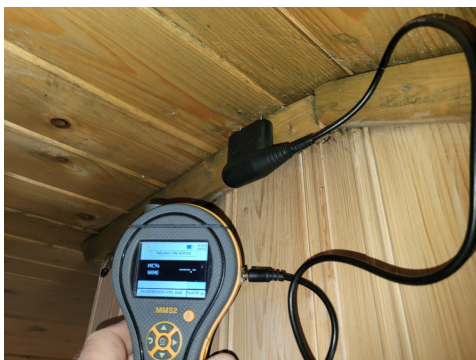
Fuktmåling i takkonstruksjon viste ingen forhøyede fuktverdier.
