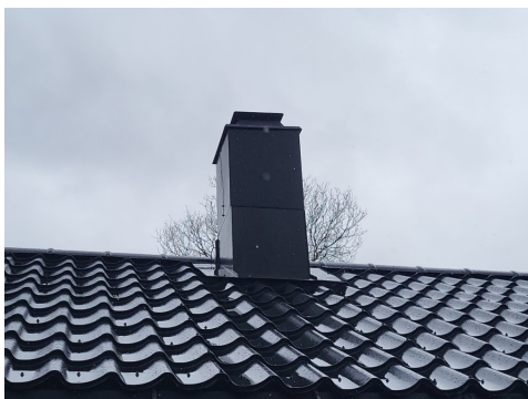
Pipe med heldekkende beslag.
