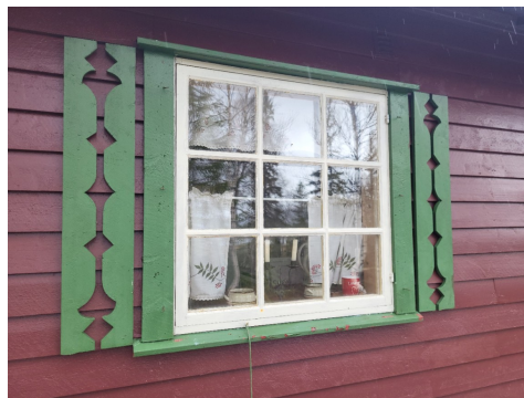
Malingsavflassing på beslag
