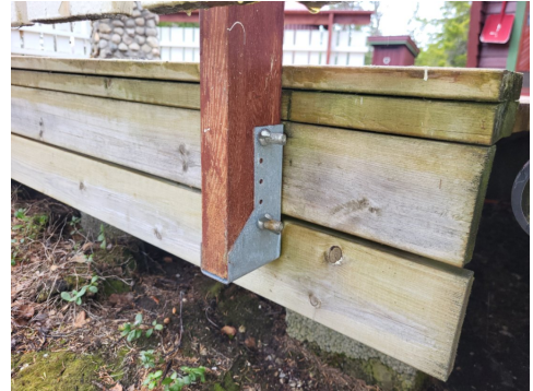
Stolpesko for innfesting av rekkverk.
