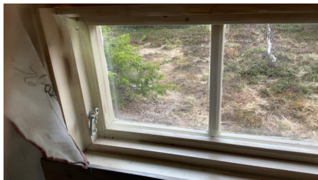
Vinduer med koblede glass.
