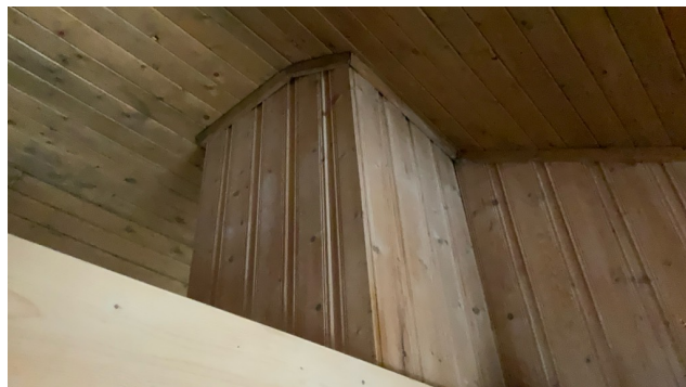
Pipa er panelt på alle sider.
