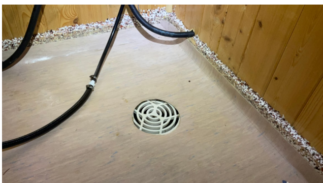
Belegg uten klemring på sluk
