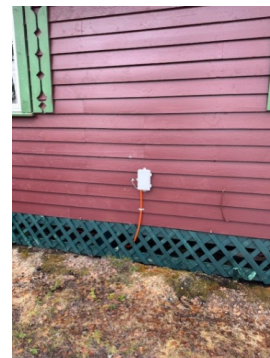
Utvendig fiberboks montert på vegg.
