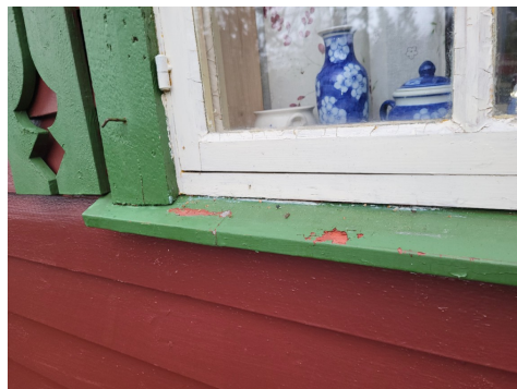
Malingsavflassing på beslag
