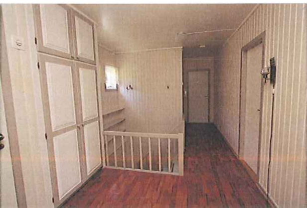
Bilde fra gang/hall – 1.etg.
